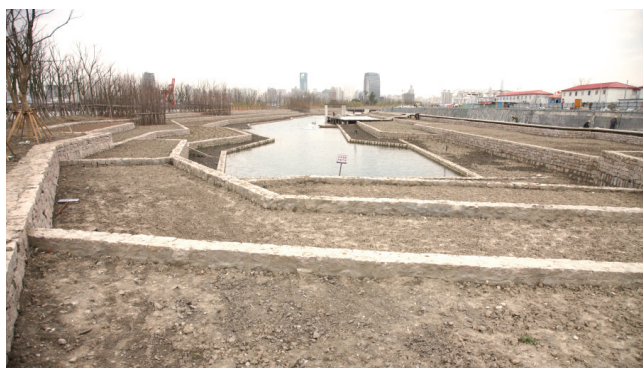
(上海後灘公園建造中)
